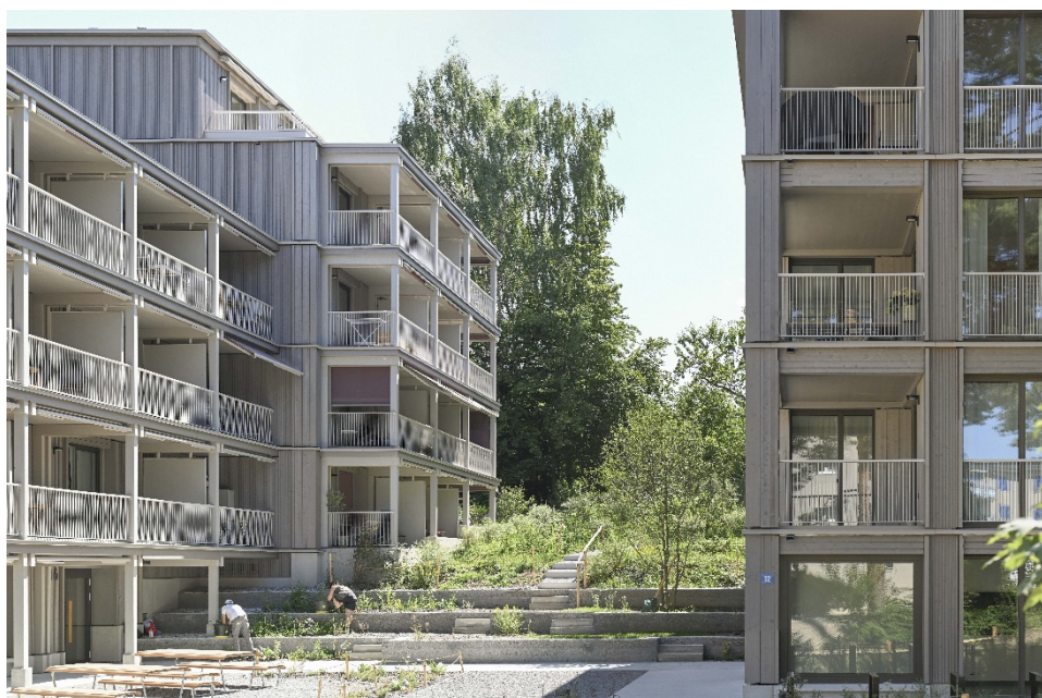
Ersatzneubau WüB „Stettbacherrain“, Zürich (Bild: © Daniele Sciarretta)
