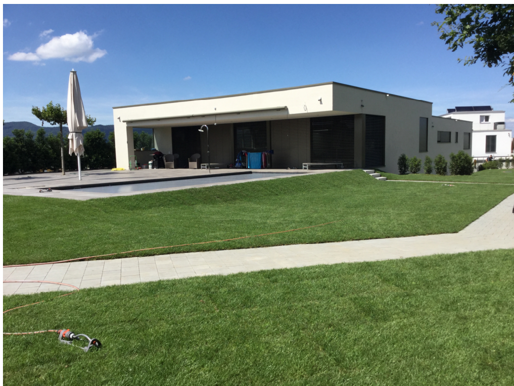
Neubau EFH, Hunzenschwil (Bild: am-architektur GmbH)
