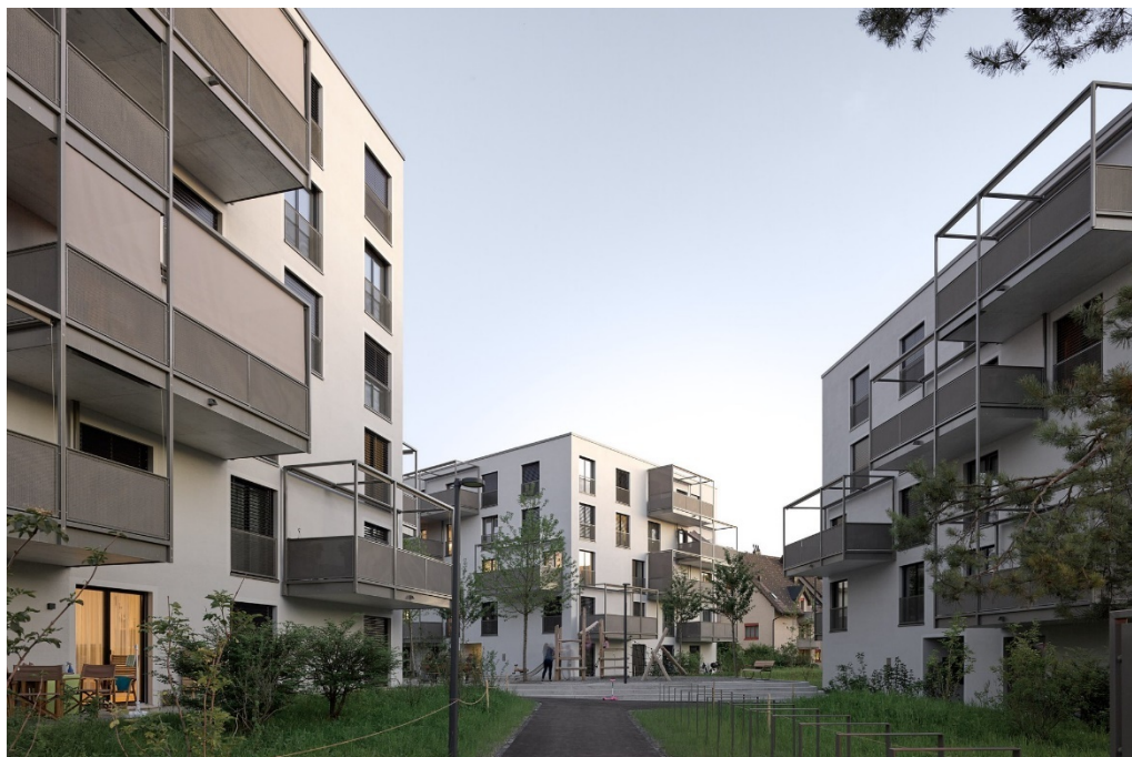
Neubau WüB „Ankenpark“, Wetzikon (Bild: Itten+Brechbühl AG)
